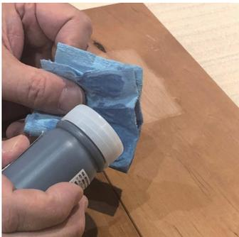
マスキングテープを剥がし、タッチアップ塗料をウエスを使用して塗る
