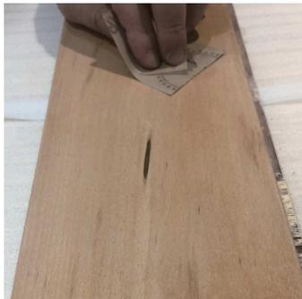
乾燥後、#400 のペーパーを使用し、表面のザラツキを軽く研磨する
