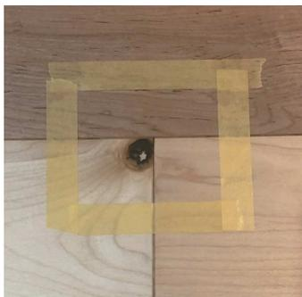
② 補修箇所をサンドペーパーで研磨する
